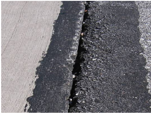
(d) Lane to shoulder separation at slab #10
