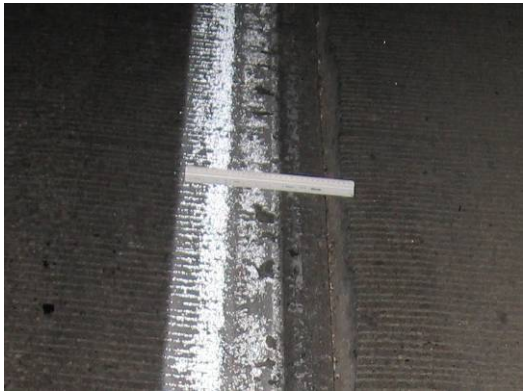
(d) Lane to shoulder separation at slab #9
