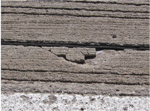
(d) Spalling of longitudinal joint at slab #13
