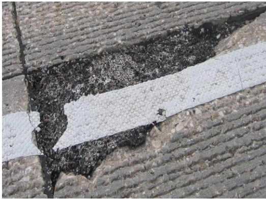
(d) Patch at slab #13
