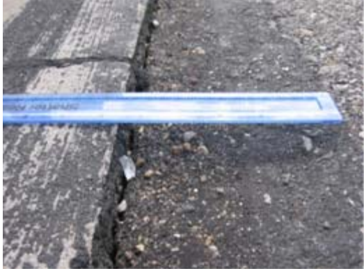
(d) Lane to shoulder drop-off at slab #20
