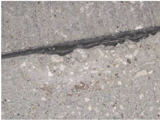
(d) Spalling of transverse joint at slab #15
