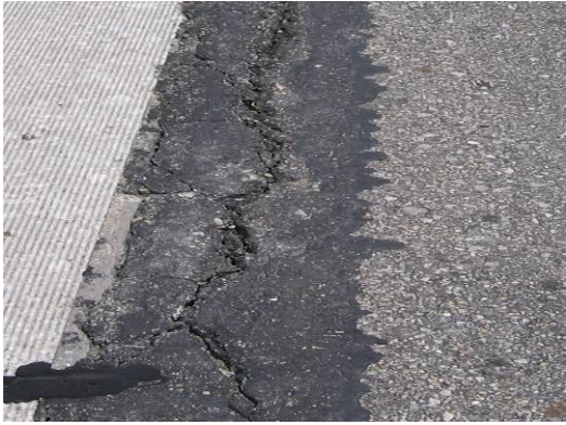
(d) Lane to shoulder separation at slab #18
