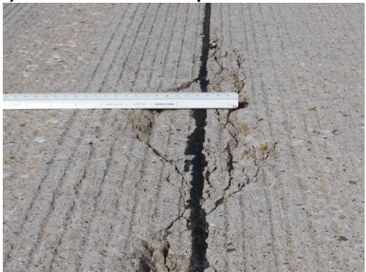
(d) Spalling of longitudinal joint at slab #8
