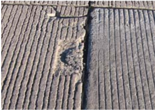
(d) Spalling of transverse joint at slab #18
