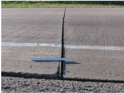
(d) Faulting joint at slab #19
